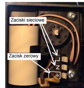
Rys. Podłączenie przewodów do pompy C.O.
